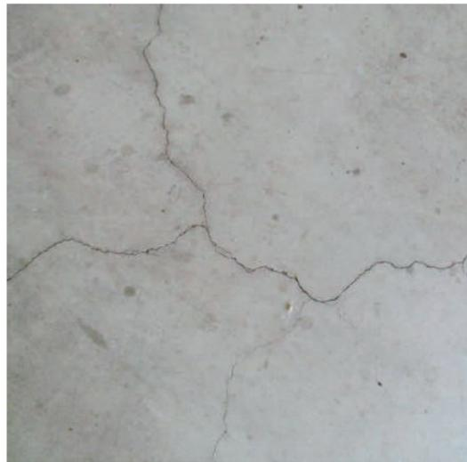
Il a été démontré depuis des années que des microfissures se produisent sur les piscines en béton suite à diverses raisons telles que le vieillissement de la structure, l'érosion ou les mouvements du terrain. Ces petites fissures de moins de 3 mm n'engendrent aucun problème au niveau de la structure mais entraînent en revanche un problème d'étanchéité.
