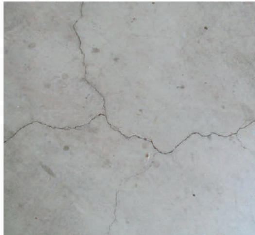
Per anni è stato dimostrato che le microfessure delle piscine in cemento si creano a seguito di diverse cause quali l'invecchiamento della struttura, l'erosione o il movimento del terreno. Le piccole fessure inferiori a 3 mm non generano un problema strutturale, ma hanno una tenuta stagna.
