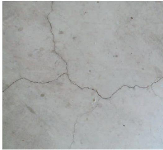
Desde hace años se ha demostrado que en las piscinas de hormigón se generan microfisuras debido a diferentes causas, tales como envejecimiento de la estructura, erosión o movimientos del terreno. Esas pequeñas fisuras de menos de 3mm no generan un problema estructural, pero sí de estanqueidad.
